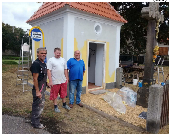
Na přiložené fotografii provádí firma pana Zdeňka Horkého závěrečné práce.
